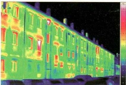
Реконструкция на сграда на Тебешрасе, Франкфурт на Майн, Германия - Реконструкция с компоненти на пасивна сграда с ефект „Фактор 10“ – десетократно намаляване на нуждата от енергия за отопление, снимка: Институт за пасивни сгради, Дармщад
